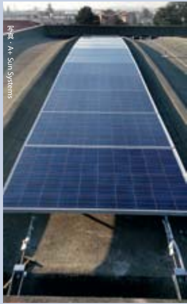
A+ Sun Systemsの引張スチールワイヤーロープ・ソリユーションSunNet Groundはラミング装置を使わなくても難易度の高いロケーションに設置できる。
